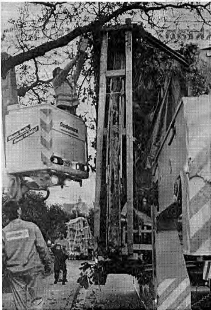
Schwertransport ins Lippische: An vielen Stellen mußte die Strecke für das Tagelöhnerhaus aus Rösebeck extra präpariert werden. Wie hier im Kreis Paderborn (Foto) wurden auch bei Willebadessen einige Bäume gestutzt.
