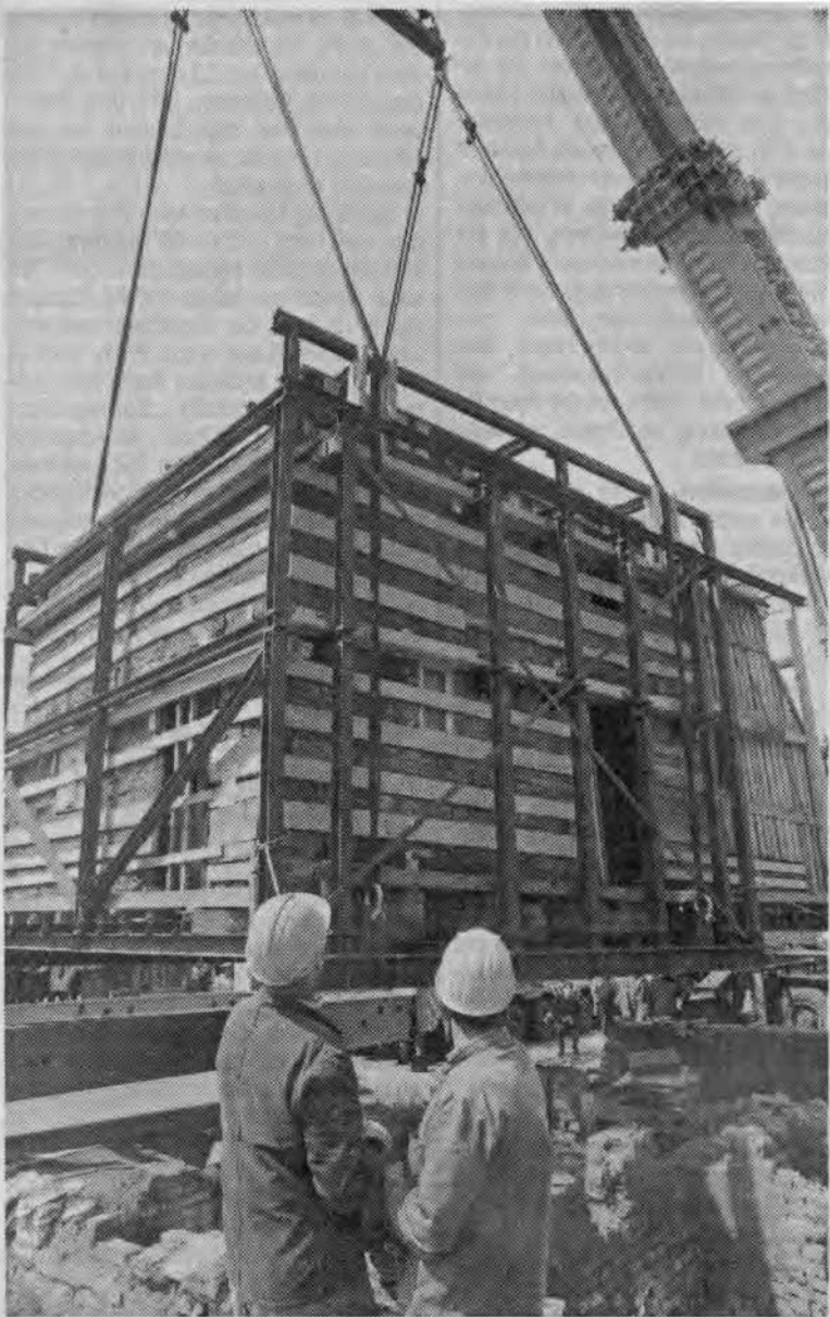
Haus am Haken. Ein 165 Jahre altes „Armeleutehaus“ aus Rösebeck bei Borgentreich in der Warburger Börde ist gestern komplett mit einem Schwertransporter ins Freilichtmuseum nach Detmold gebracht worden. Die Aktion mit dem 80 Tonnen schweren Häuschen kostete den Landschaftsverband Westfalen-Lippe 120 000 Mark (siehe auch Bericht im Inneren der Zeitung).
