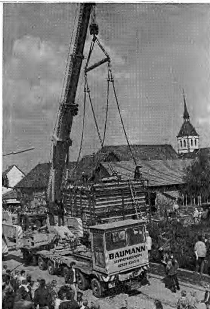
Schweres Gerät: Ein 450-Tonnen-Kran nimmt das 80 Tonnen schwere Häuschen im Bördedorf Rösebeck an den Haken.
