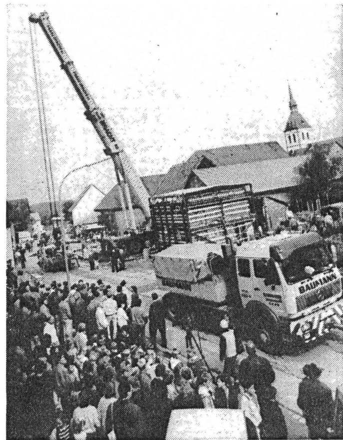
Ein gutes Jahr nachdem das kleine Querdeelenhaus aus Rösebeck im Stahlkorsett komplett nach Detmold transportiert wurde, kann es jetzt wieder eröffnet werden.
